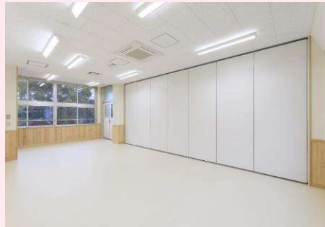
学習室は2室に仕切って使うことができます。左の写真の後ろの壁の左にある部材を天井にあるレールに沿って順に動かしていくと、右の写真のように間仕切壁となります。
