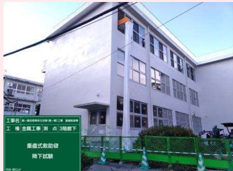
3-1の廊下に設置してある救助袋は非常時の避難に利用します。箱から袋を取り出し、右の写真のように窓の外に設置して、袋の中を降下して地上へと避難します。
