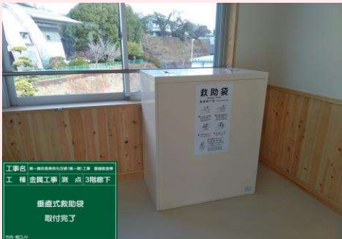
3-1の廊下に設置してある救助袋は非常時の避難に利用します。箱から袋を取り出し、右の写真のように窓の外に設置して、袋の中を降下して地上へと避難します。
