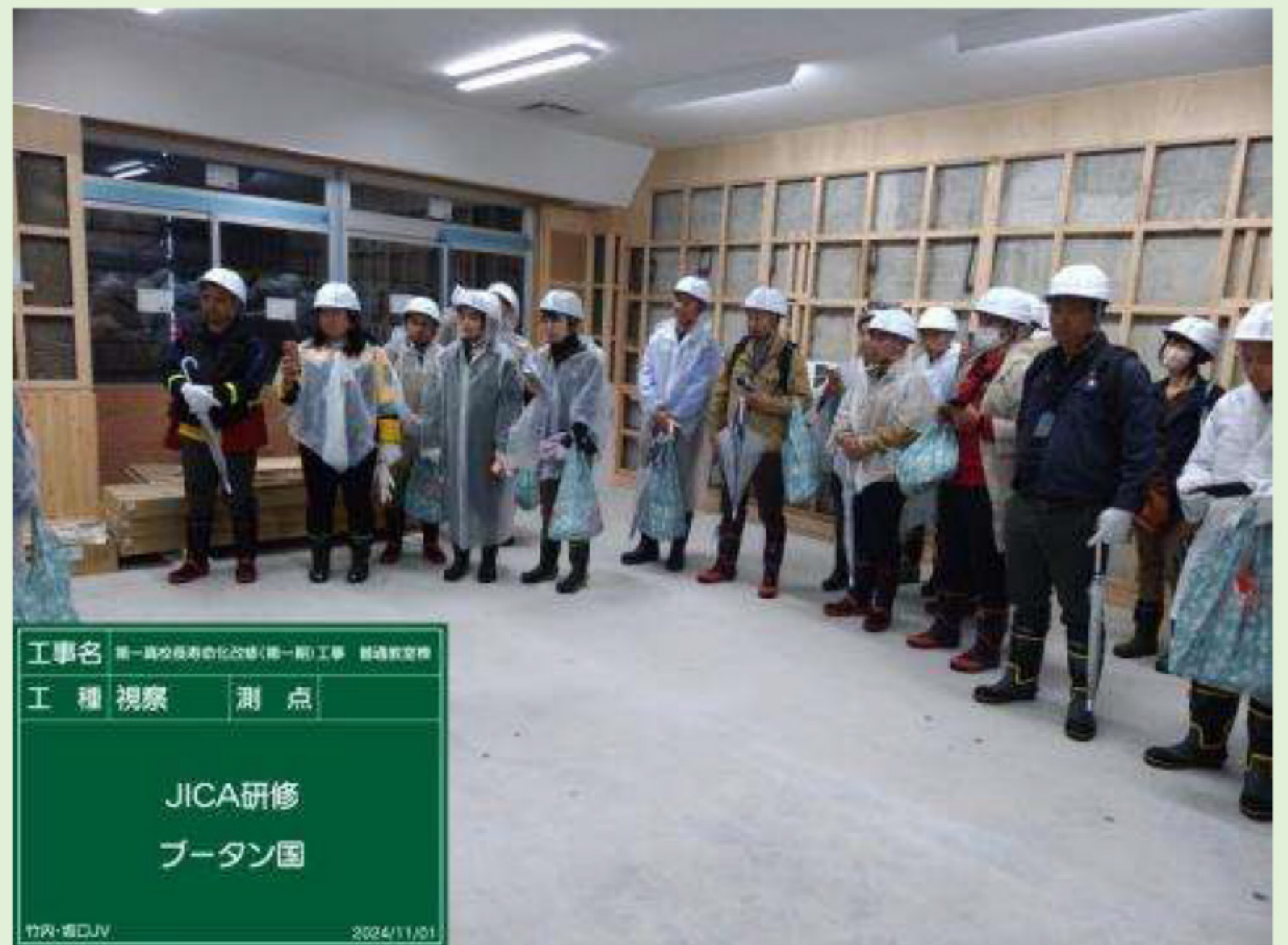
工事現場にて施工者より説明
