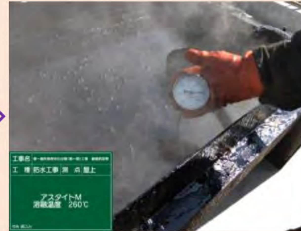
⑤アスファルト溶融 アスファルトを溶かし、260℃程度にします。
