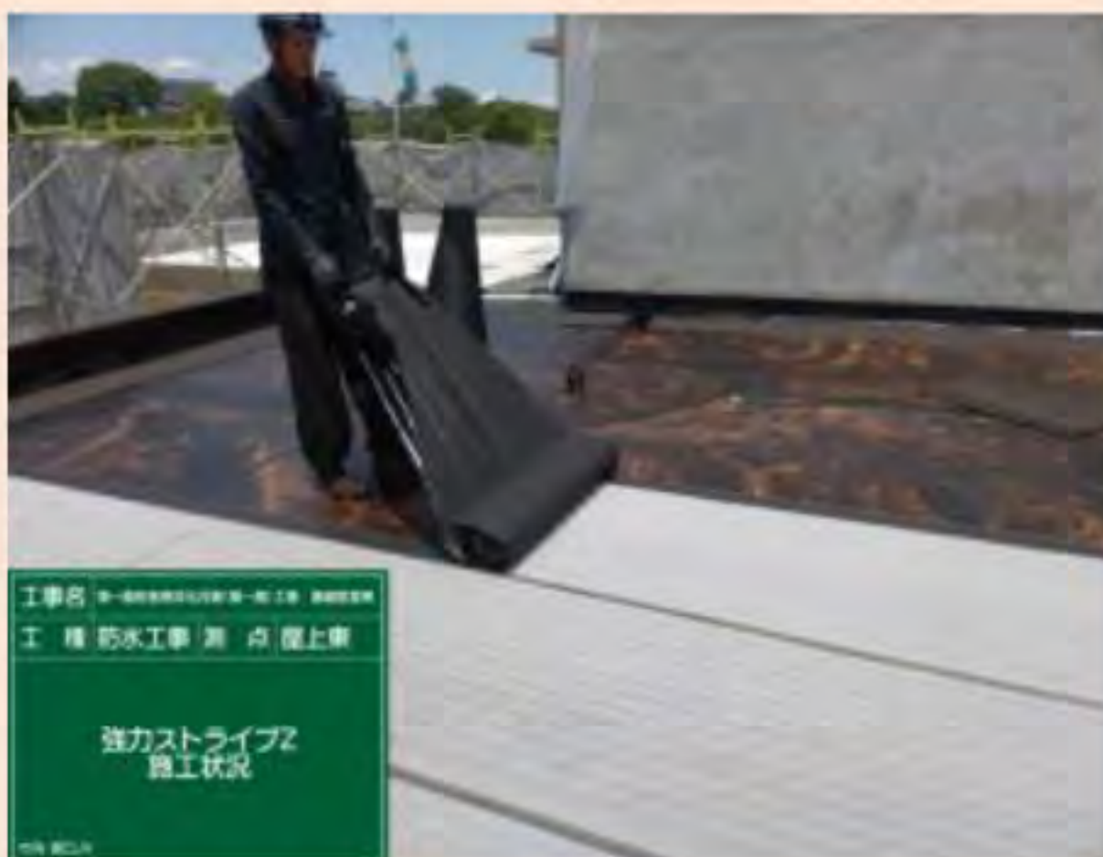
④改質アスファルトルーフィング張り 剥離紙をはがしながら、しわが入らないように貼り付けていきます。
