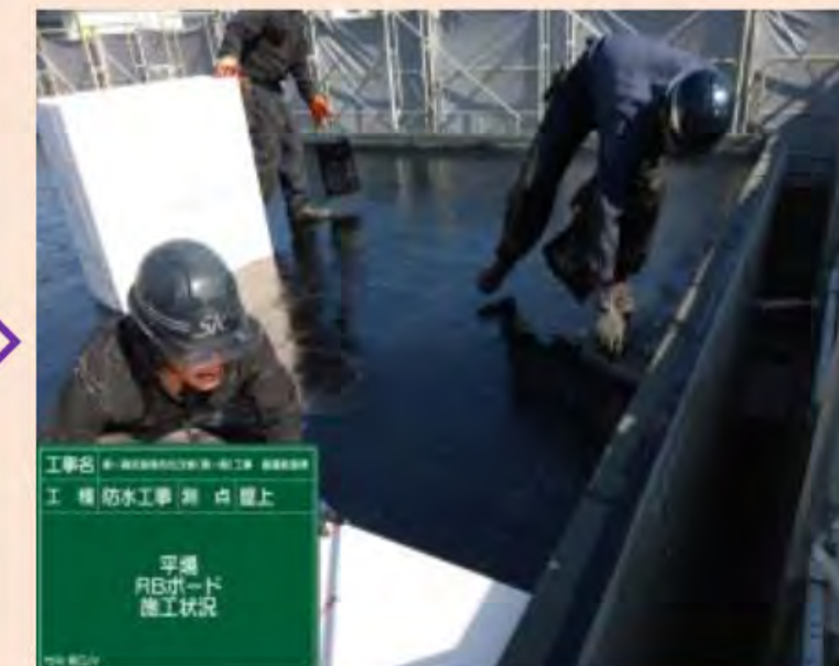
⑧断熱材の施工 アスファルトにて断熱材（厚さ4センチ）を張り付けます。
