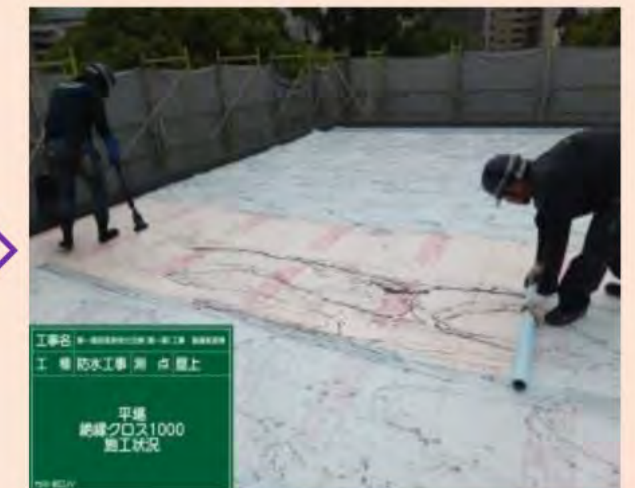
⑨絶縁クロス張り アスファルトで絶縁クロスを点張りします。
