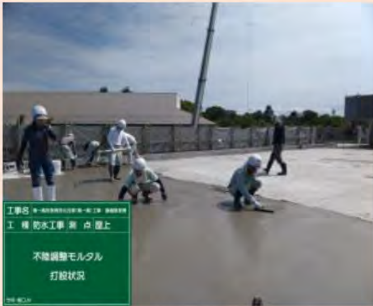
①不陸調整モルタル打設 解体後のデコボコした部分を平滑にします。
