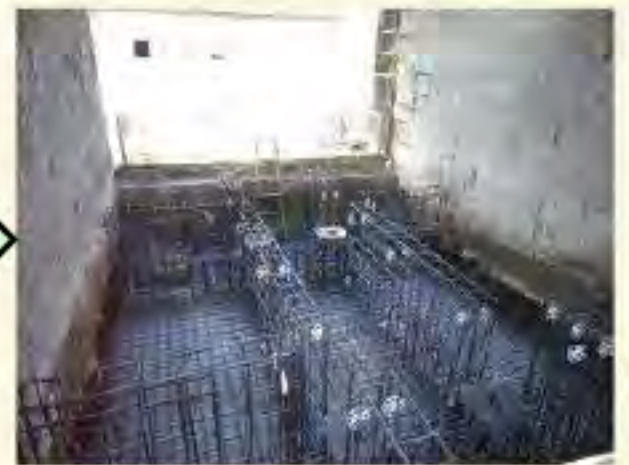
○階段の基礎工事
