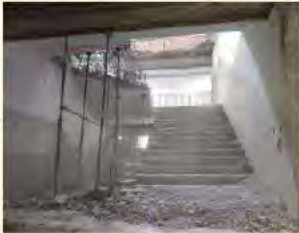
○解体中の階段
