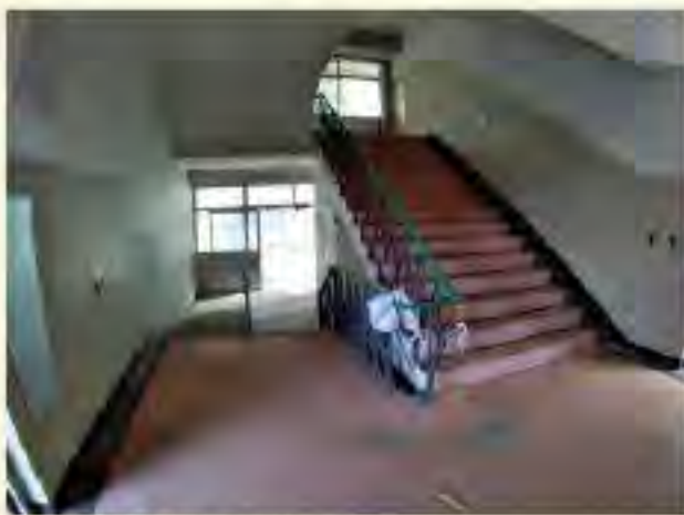
○解体前の階段
