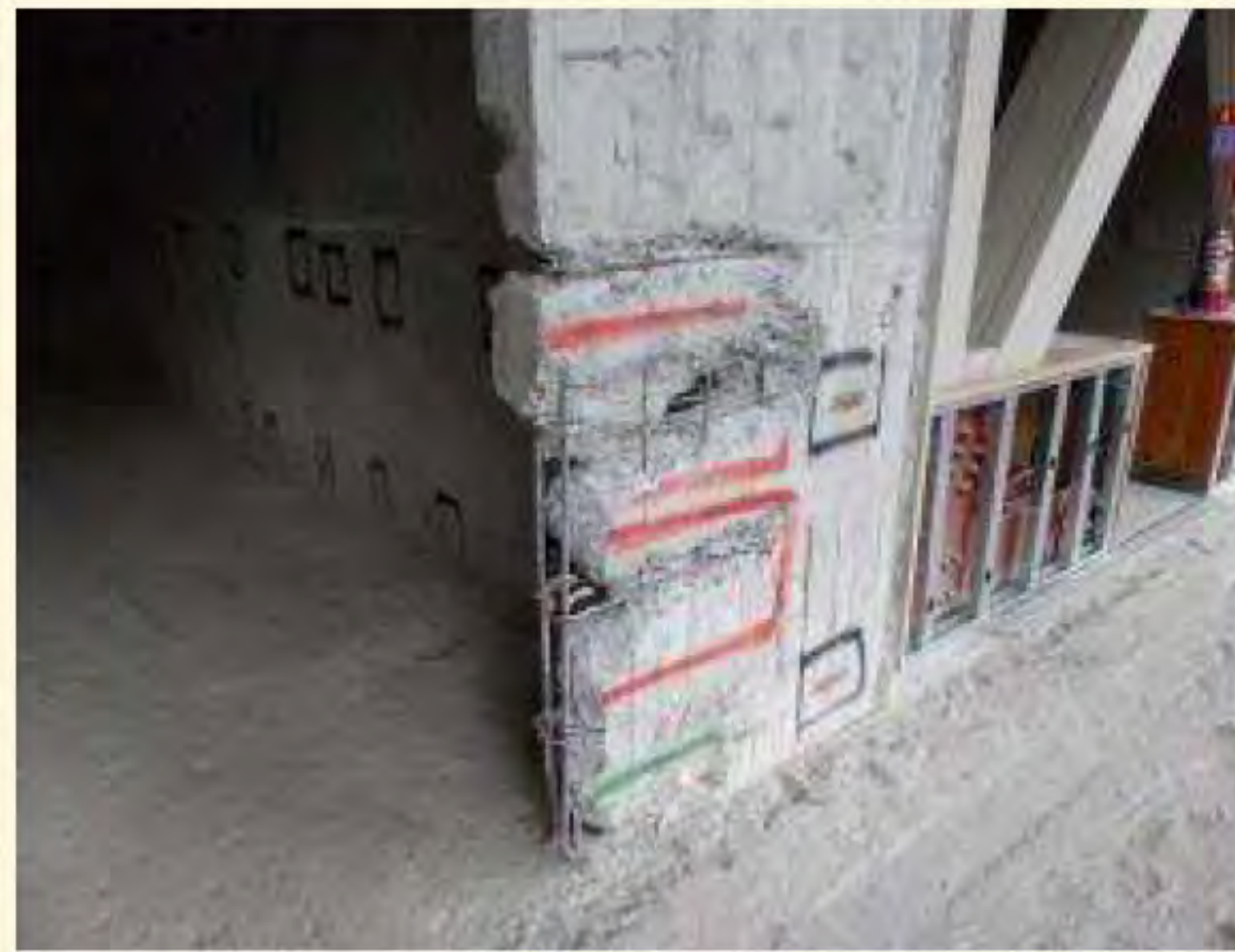
劣化部分をはつった壁
