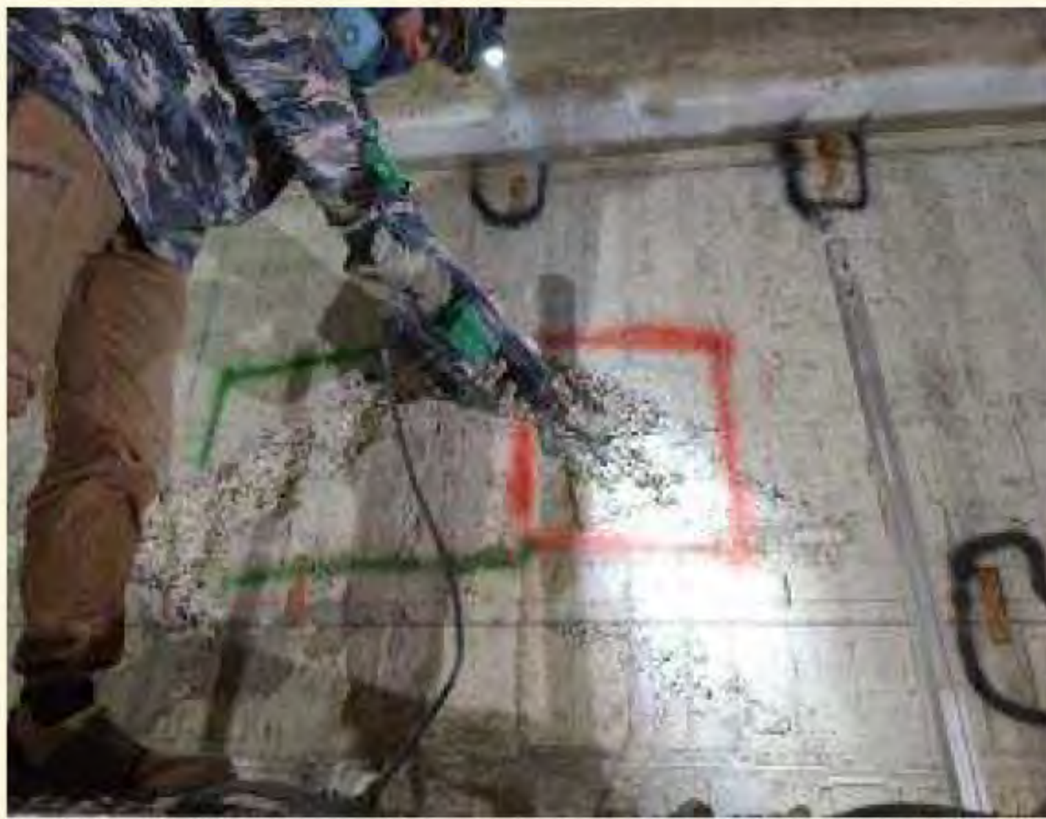
劣化部分のはつり状況
