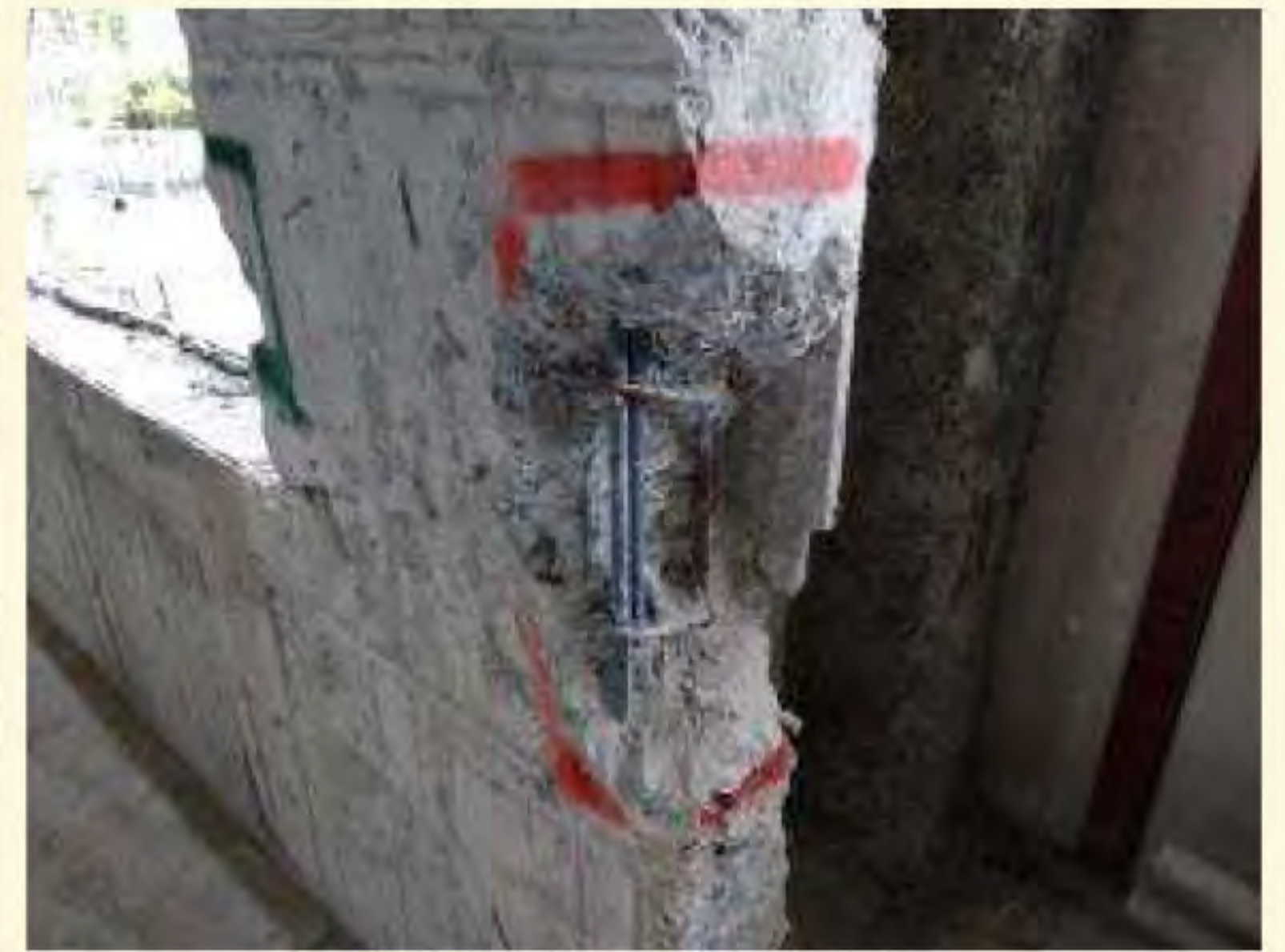
劣化部分をはつった壁
