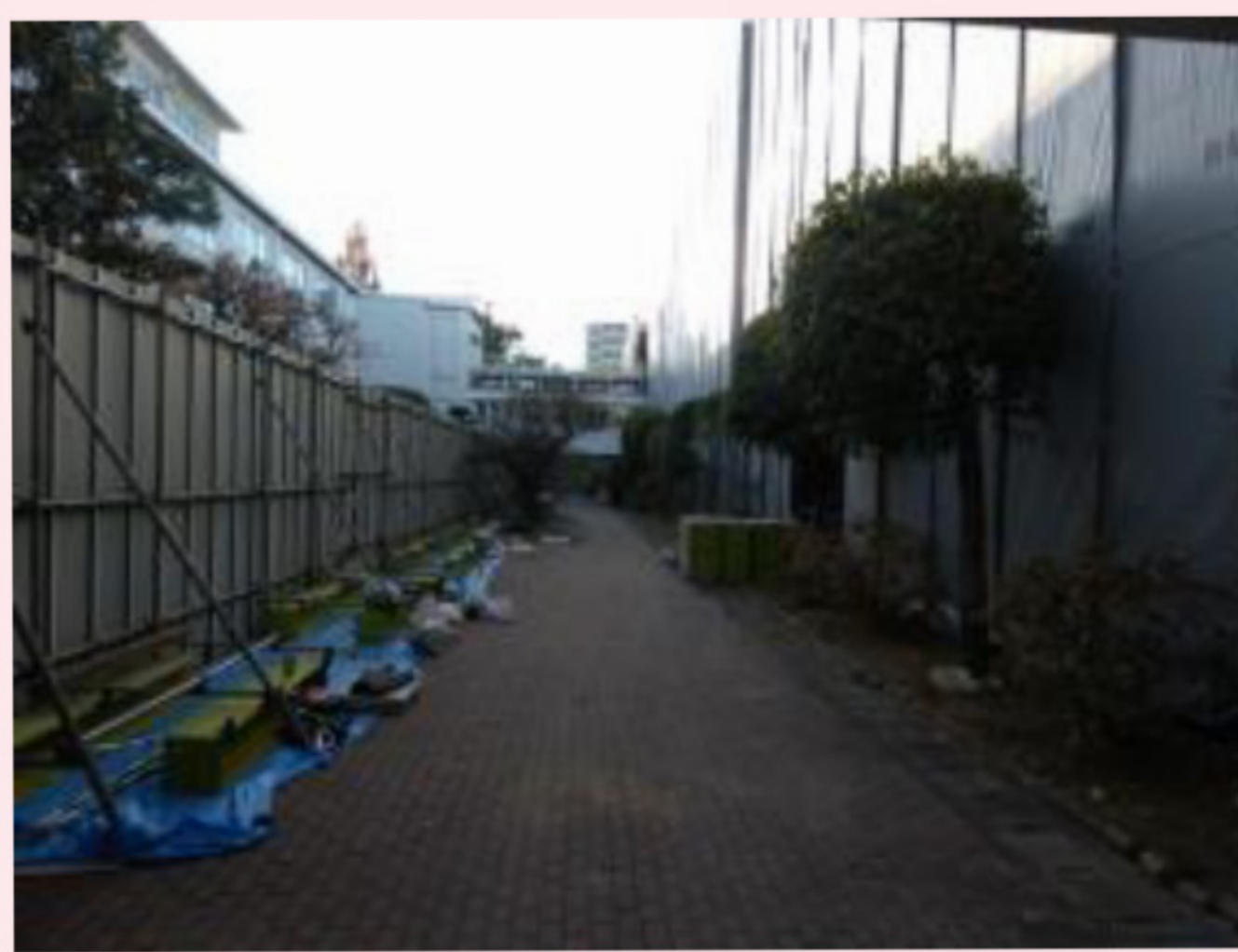
普通教室棟南側
