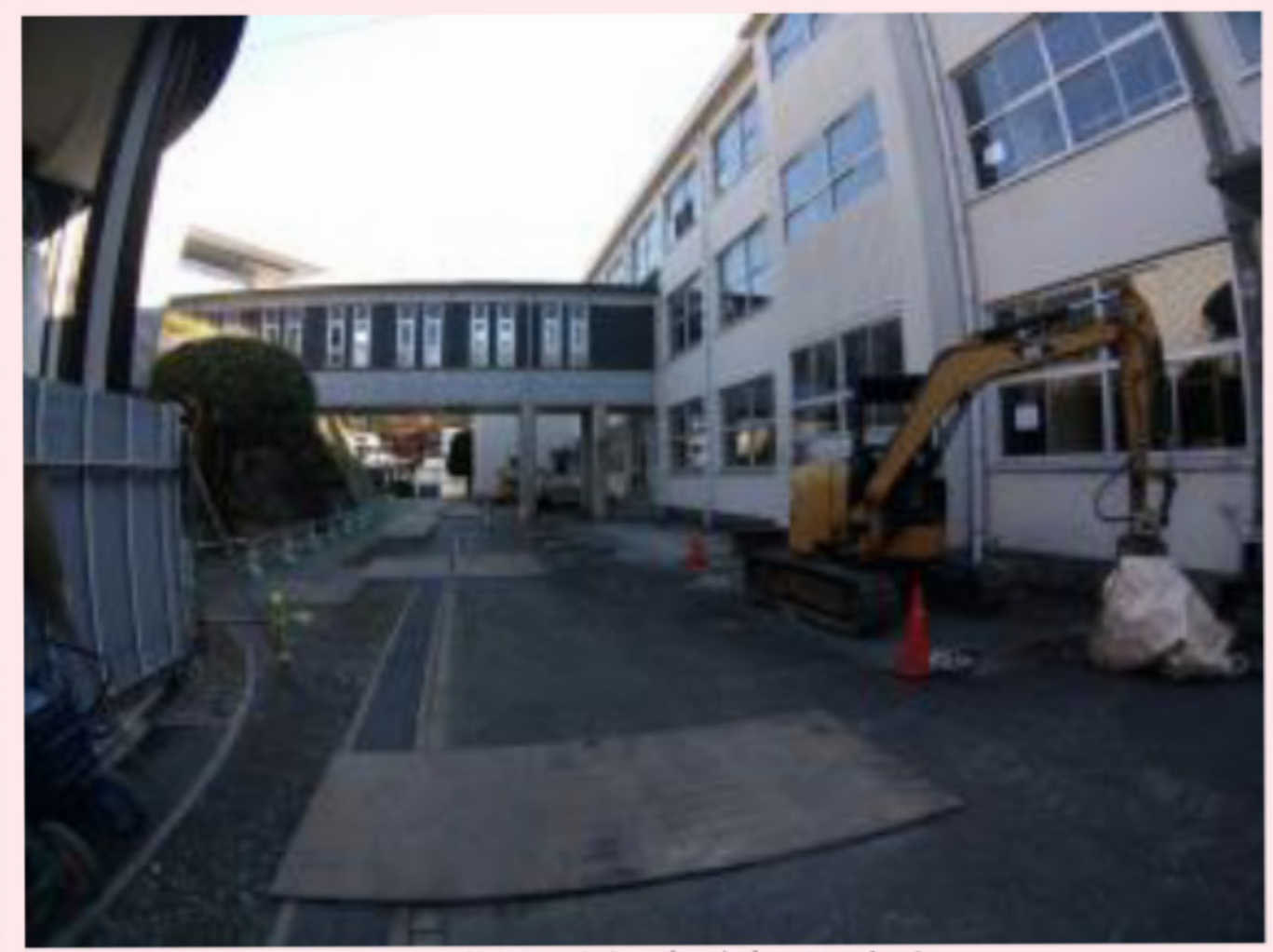
普通教室棟北側
